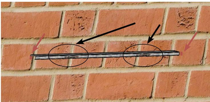
Utiliser une traverse pour marquer, sur la façade, les bords des traverses ainsi que les 2 trous oblongs pour le perçage
