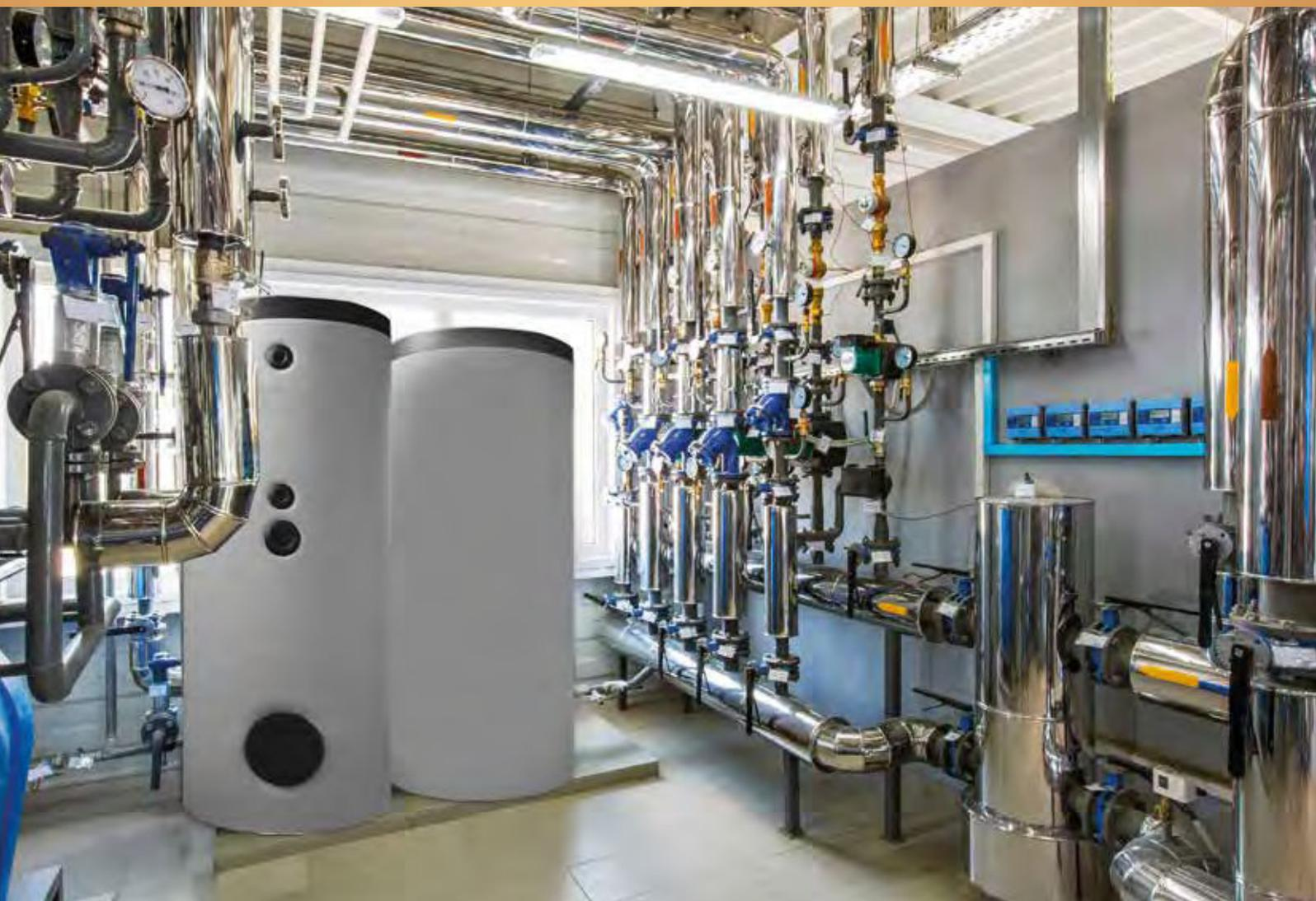
Los acumuladores de la serie BVE-WW están especialmente diseñados para instalaciones solares con circuito primario. Están equipados con dos serpentines.
