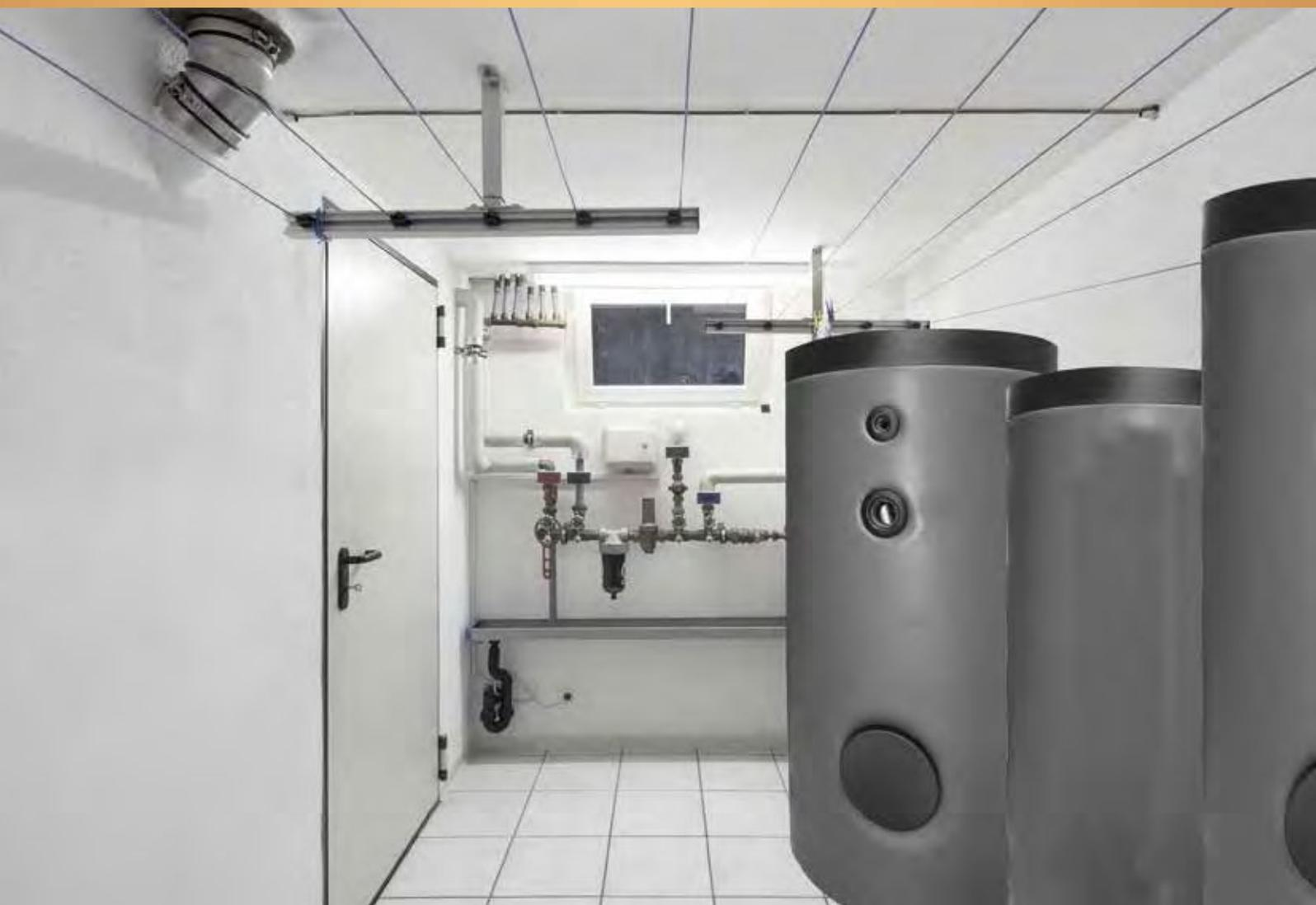
Los acumuladores de la serie BVE-W están especialmente diseñados para instalaciones solares con circuito cerrado primario. Están equipados con un serpentín. El tanque y el serpentín son de acero vitrificado. Las bocas del intercambiador se sitúan en el lateral trasero del acumulador, independientemente de la entrada de agua fría y la salida de agua caliente sanitaria, situada en la parte delantera. Estos acumuladores se instalan en el suelo.
