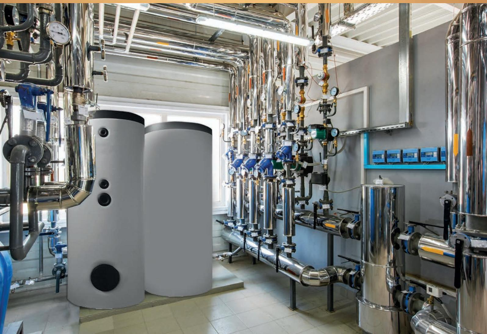
Les ballons de la série BVE–WW sont spécialement conçus pour des installations solaires avec circuit primaire. Ils sont équipés de deux échangeurs. La cuve et les échangeurs sont en acier émaillé. Ces ballons sont à poser au sol, et sont généralement utilisés en combinaison d'une production solaire (sur l'échangeur du bas) avec appoint par une chaudière ou une pompe à chaleur (sur l'échangeur du haut).
