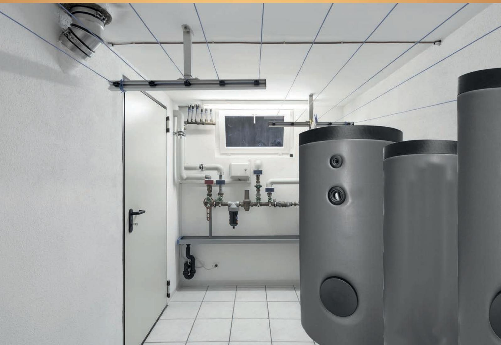
Les ballons de la série BVE-W sont spécialement conçus pour des installations solaires avec circuit primaire. Ils sont équipés d'un échangeur. La cuve et l'échangeur sont en acier émaillé. Les piquages de l'échangeur sont situés sur le côté à l'arrière du ballon, indépendamment de l'entrée eau froide et sortie eau chaude sanitaire situées en face avant. Ces ballons sont à poser au sol.
