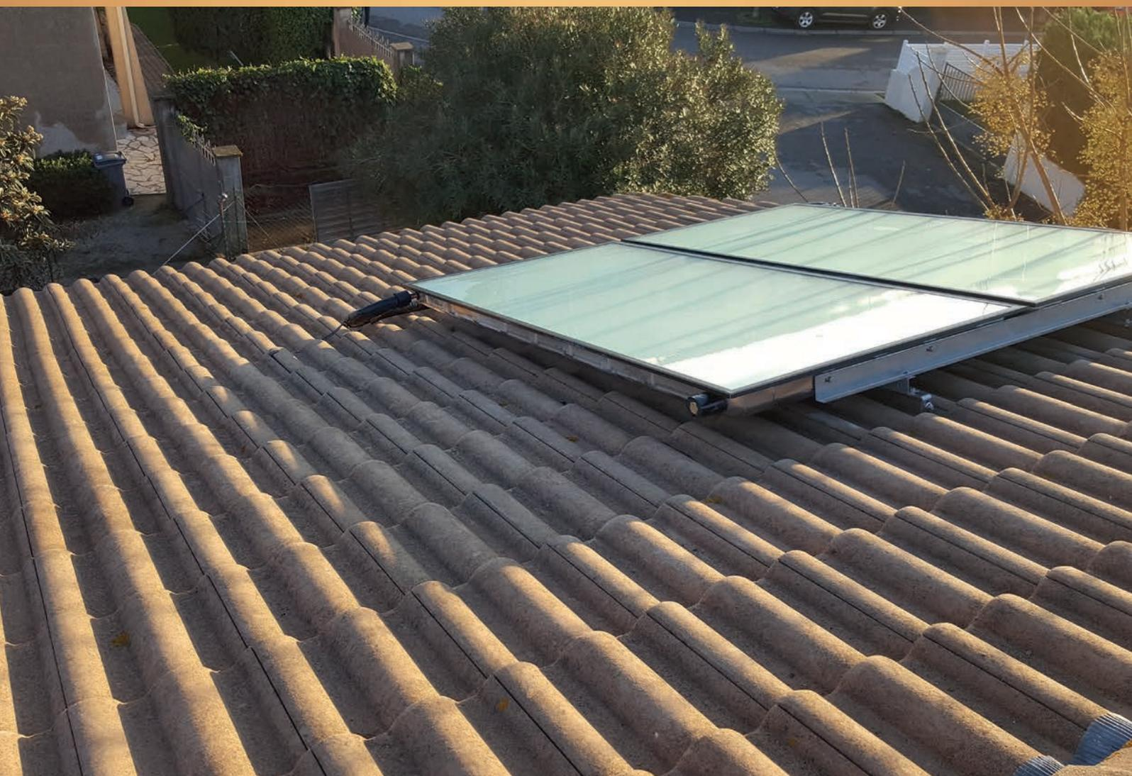
Le chauffe-eau solaire drain back est un chauffe-eau solaire individuel autovidangeable avec une station de régulation intégrée.
