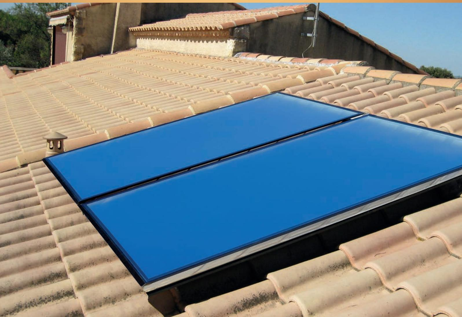
Le chauffe-eau solaire individuel est composé d'un ou plusieurs panneaux solaires, d'un ballon de stockage et d'une régulation. Le nombre de panneaux dépend de la zone géographique et du nombre de personnes habitant dans le logement. Le ballon peut être alimenté par une énergie d'appoint par le biais d'une résistance électrique, une pompe à chaleur ou autres chaudières (gaz, fioul, bois).
