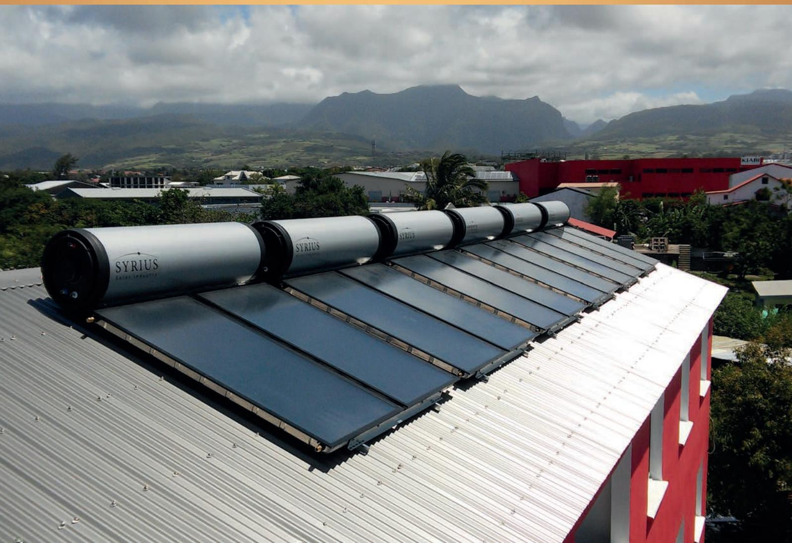
El calentador solar termosifón se compone de uno o más captadores solares y de un acumulador de agua caliente horizontal, sobre los captadores, en el tejado.
