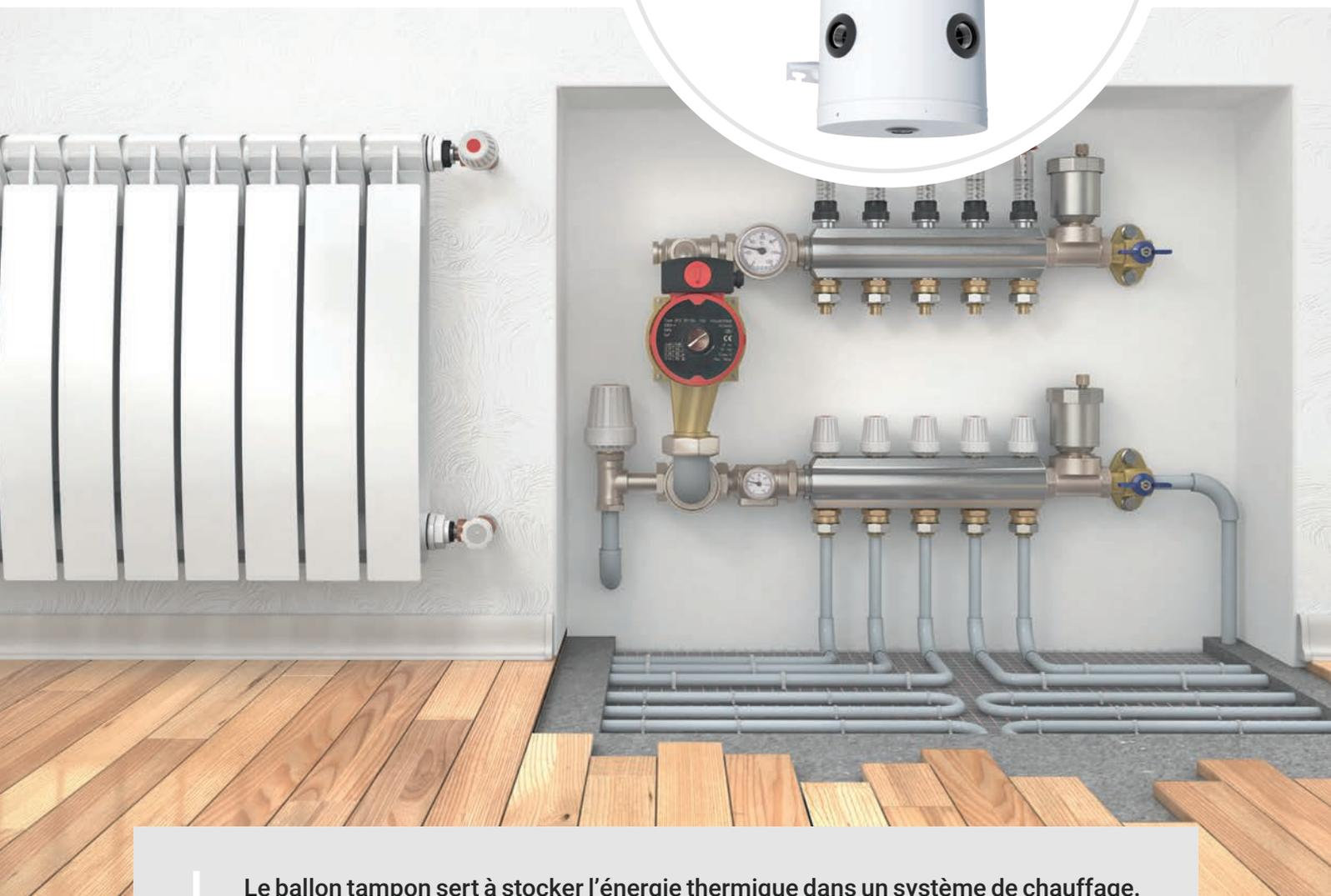
Le ballon tampon sert à stocker l'énergie thermique dans un système de chauffage.
